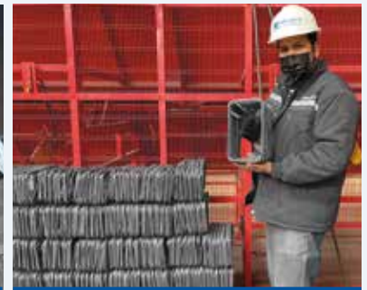
Elemento listo para armado
